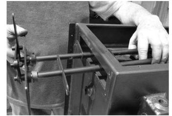
A seguito della pulizia del vano superiore della sezione di scambio, riporre il coperchio superiore di chiusura.
