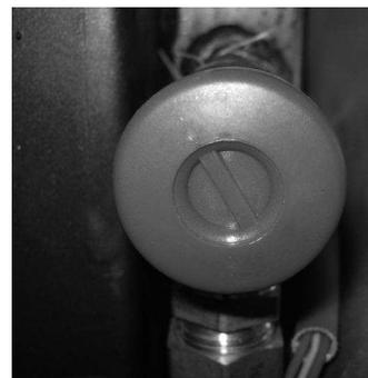
**Valvola di sicurezza:** questa valvola interviene per prevenire una sovrappressione dell'impianto idraulico. Se la pressione della termostufa o dell'impianto supera i 2,5 bar essa scarica l'acqua dal circuito.
