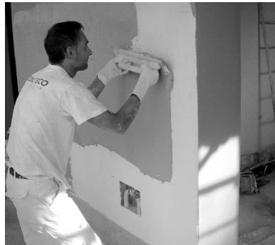
c. Une fois le ragréage est totalement secs, tant point b, faire un ragréage total des panneaux avec un produit adéquat (de type Ecap FM ou Isolteco Rasatura Monocap dans la granulométrie souhaitée). Le ragréage sera ensuite tiré avec une planche à dresser. L'épaisseur du ragréage devra être de 0,2 cm maximum.
