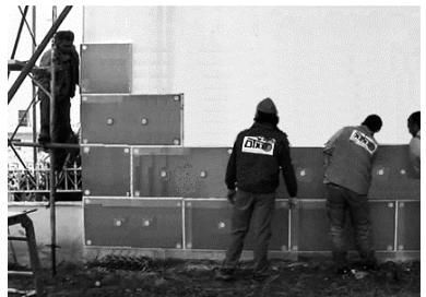
Ceci est indispensable pour obtenir une superposition correcte du treillis de recouvrement et pour recouvrir les chevilles qui seront installées par la suite. Afin d'obtenir un résultat parfait, utiliser une règle en aluminium pour corriger d'éventuelles différences de niveau entre les panneaux et obtenir ainsi une surface totalement plane.
