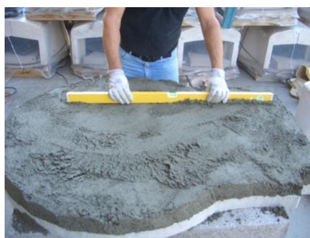
Predisposizione dello strato di coibentazione inferiore di 7 cm di argilla e cemento
