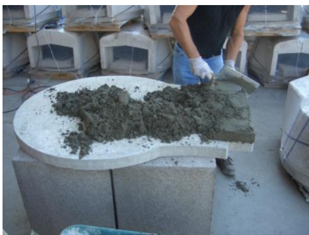
Predisposizione dello strato di coibentazione inferiore di 7 cm di argilla e cemento
