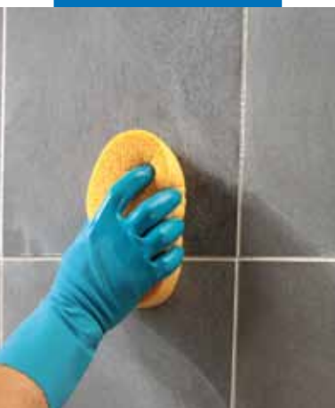
Finitura della superficie con spugna di cellulosa dura
