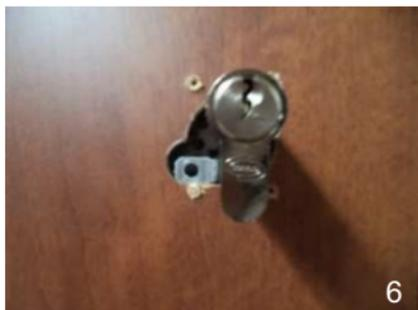
Bloccare il cilindro sulla serratura con la vite FIG 8
